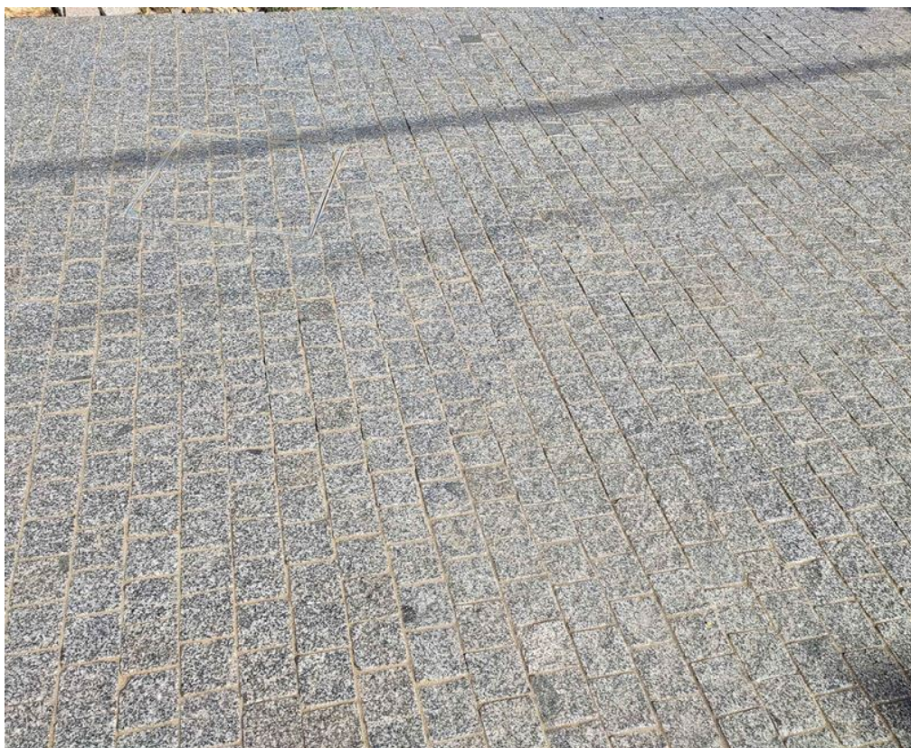
Obrázek 1: žulová kostka 80/80 s řezanými bočními stěnami
